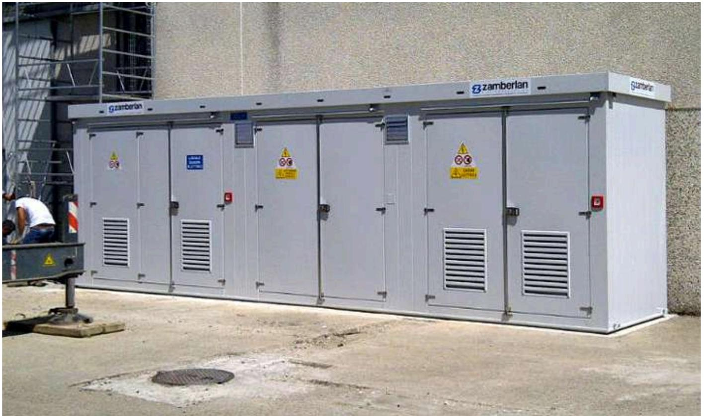
**Shelter per campo fotovoltaico** - Locale QBT / trafo / locale QMt - Dim. 9000x2400x h2700 mm
