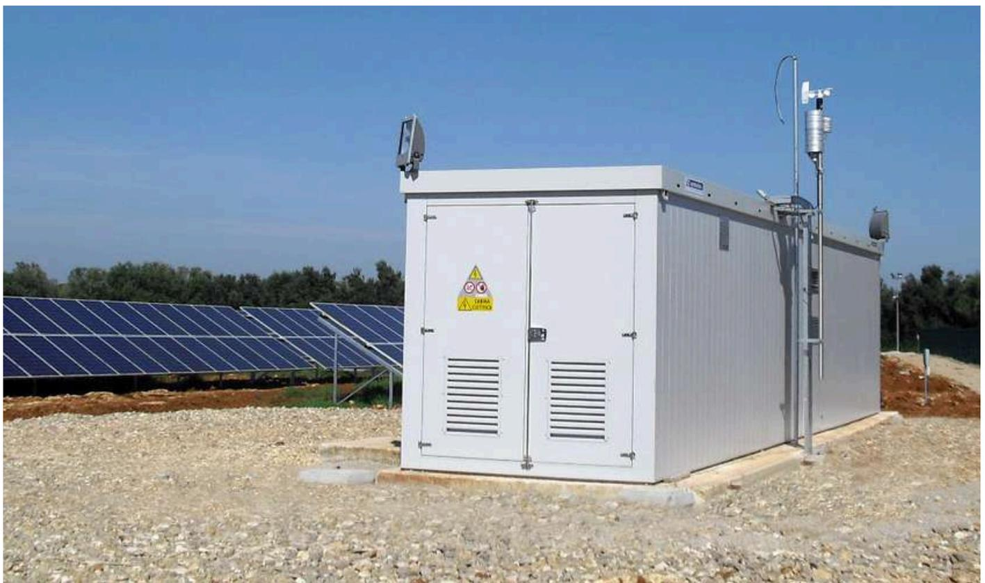
**Shelter per QMT+TRAFO - Locale QMT / trafo - Dim. 5200x2400x3230 mm**
