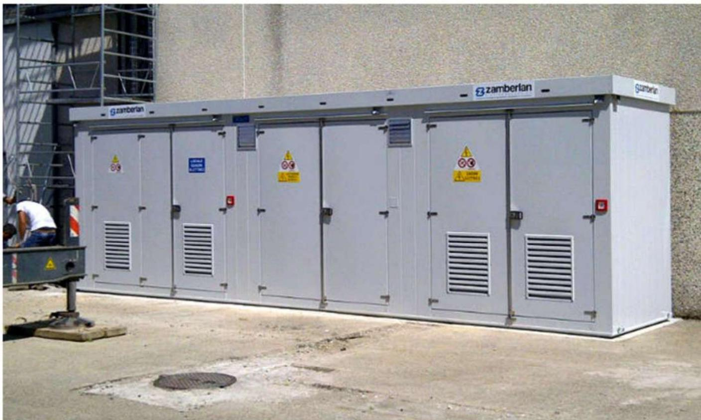
Shelter per campo fotovoltaico - Locale QBT / trafo / locale QMt - Dim. 9000x2400x h2700 mm
