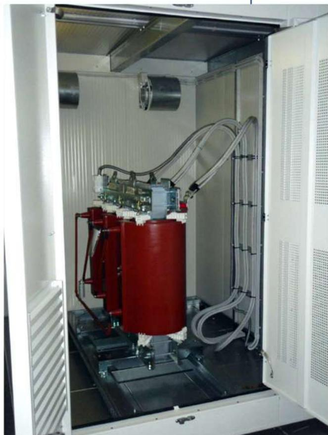
**Shelter per QMT+TRAFO - Locale QMT / trafo / locale inverter climatizzato Dim. 8400x2400x h2930 mm**
