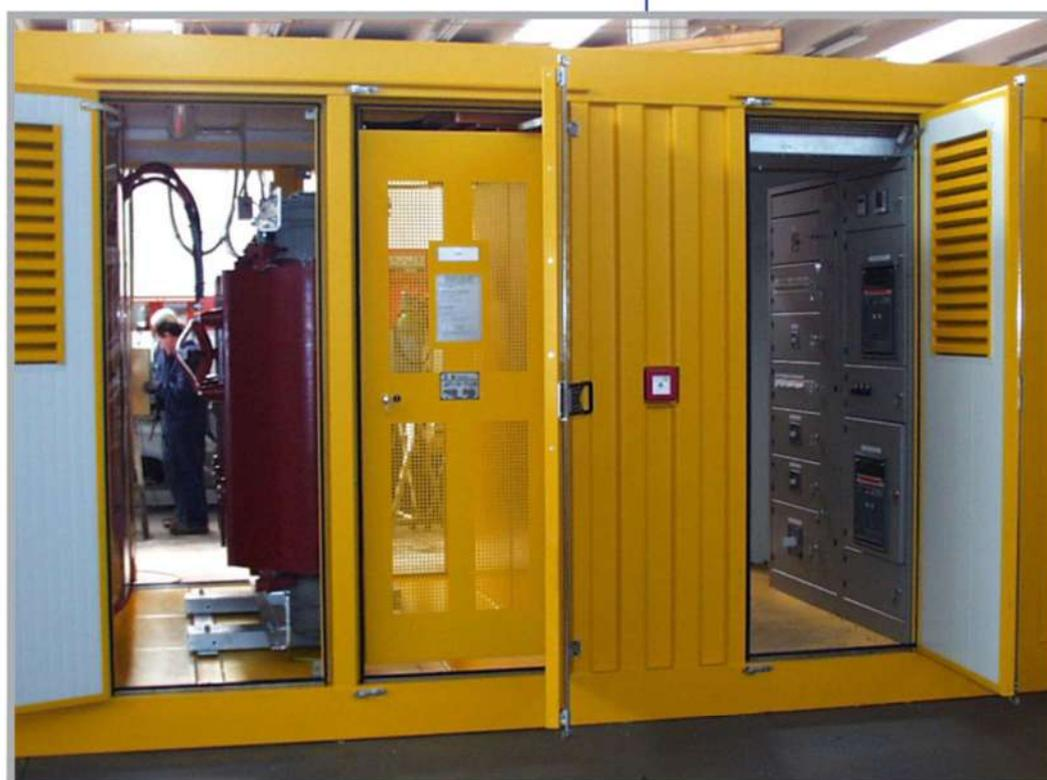
**Stazione inverter per fotovoltaico - Locale QBT - QMt inverter / locale trafo - Container 20'**
