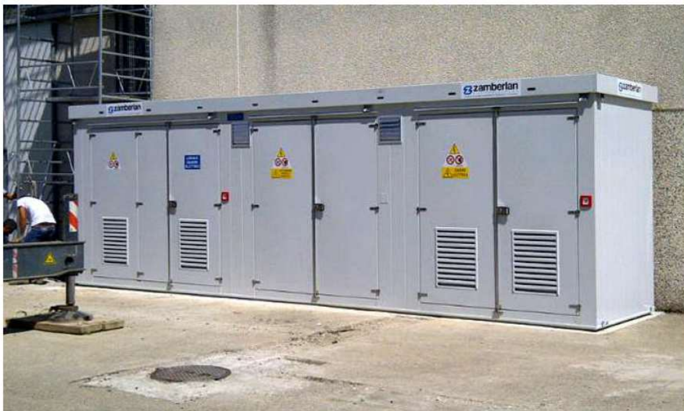
Shelter per vano tecnico - Locale QBT / Trafo / Locale QMT - Dim. 8400x1800x h2880 mm
