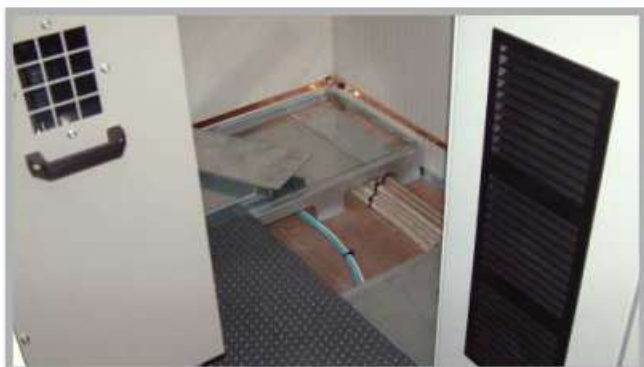
Esecuzione con pavimento flottante per il passaggio cavi
