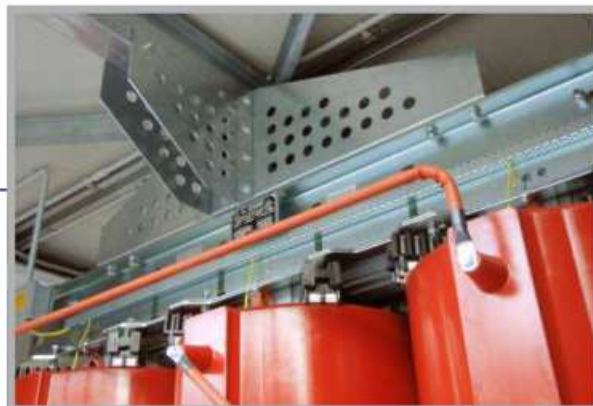
Staffe fissaggio cavi e pavimento asportabile
