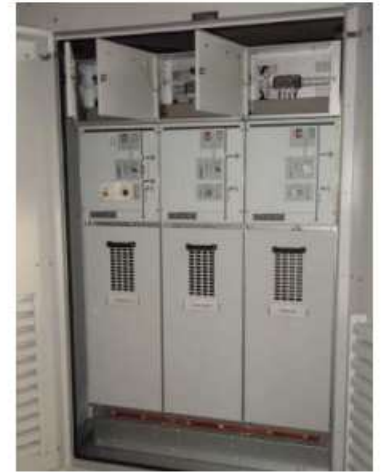
Vista interna QMT accessibile direttamente aprendo i portelloni
