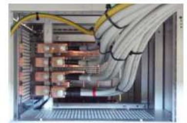
Collegamento cavi trafo-interruttore generale
